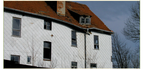
Das Verwaltungsgebäude der ehemaligen Porzellan- fabrik Elgersburg wird abgerissen. Foto: ThLG
